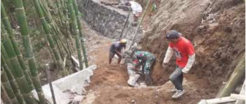
Gambar 9. Gotong Royong Pembuatan Talud Di Pakis Magelang
