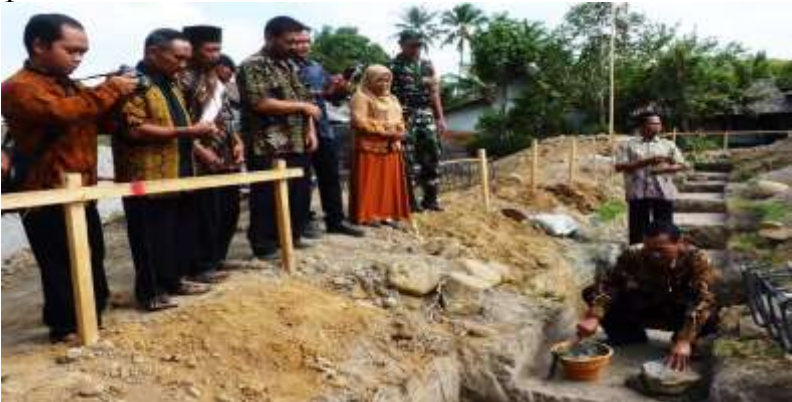
Gambar 20. Pembangunan Tempat Evakuasi Akhir di Mangunsari Magelang
