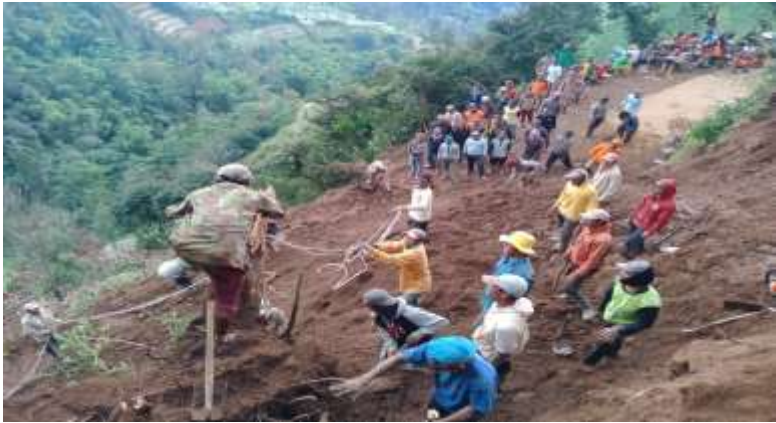
Gambar 12. Gotong Royong Memperbaiki Akses Jalan Saat Longsor Di Lereng Merapi
